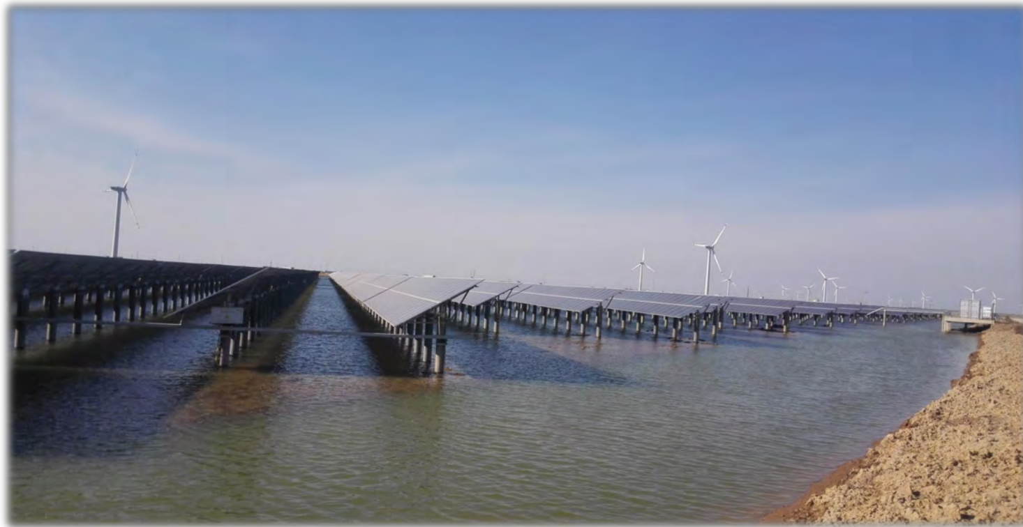
常州亿晶光电科技有限公司直溪100MW p 渔光互补光伏发电项目
