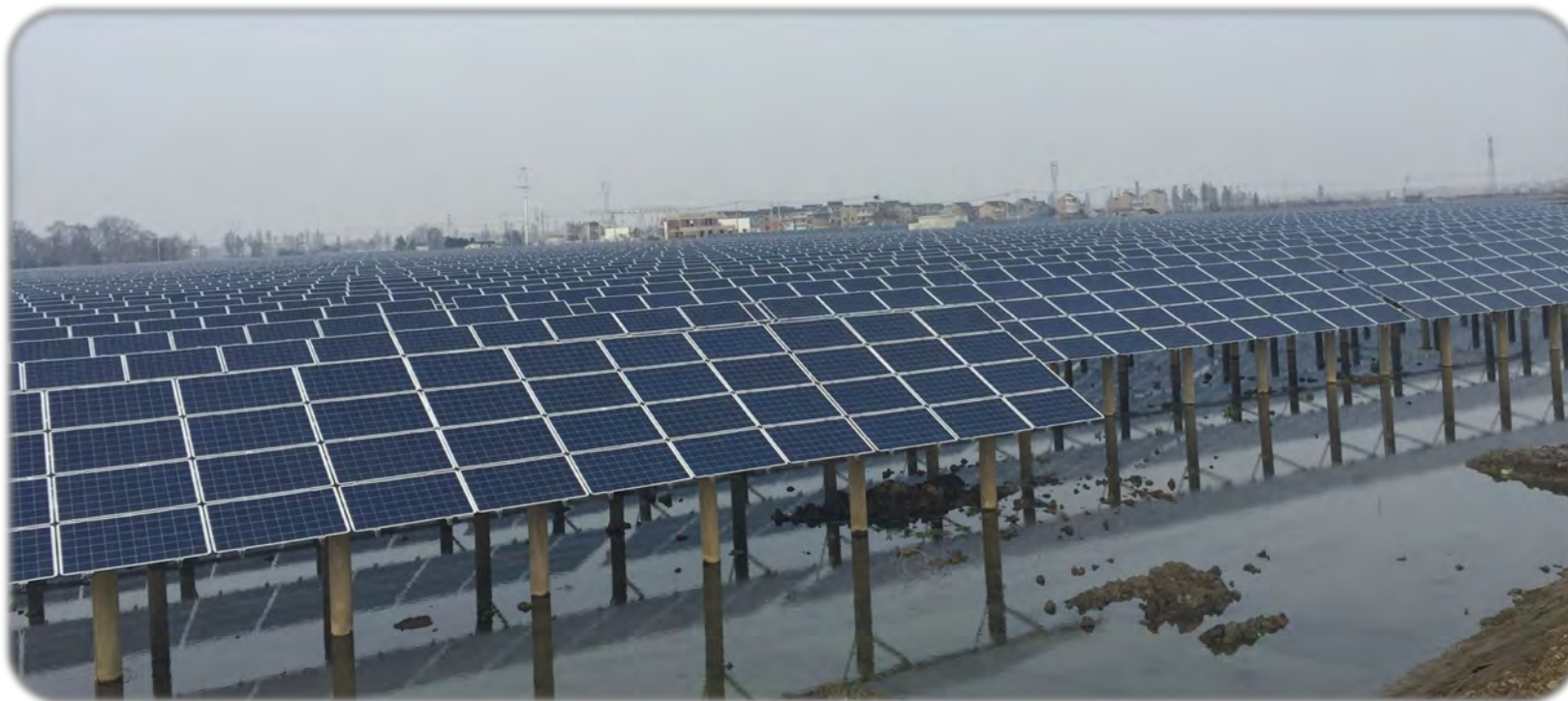
溧阳别桥华鹏30MWp渔光互补光伏发电项目
