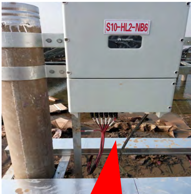
逆变器插头直流线 缆脱落
