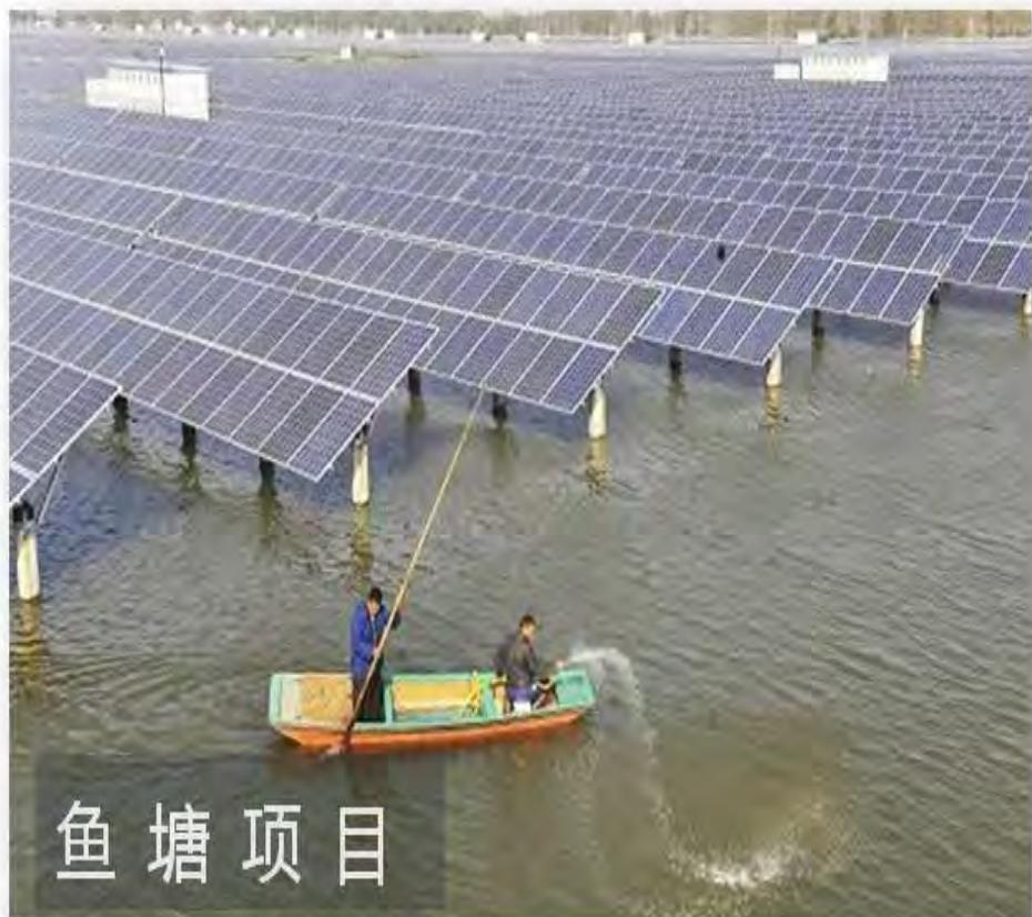
光伏发电对渔业的影响：“渔光互补”条件下水产养殖存在的主要问题是太阳能电池板遮挡阳光，造成水温偏低，会对水产品的正常生长有一定的影响。
