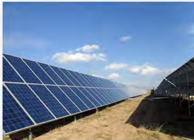
一般横向4排，前后排部分遮挡时，未遮挡部分可以继续发电，冬季发电量比竖向排布高2~3%以上，全年约0.5~1%
