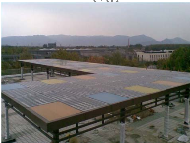
光伏长廊全景
