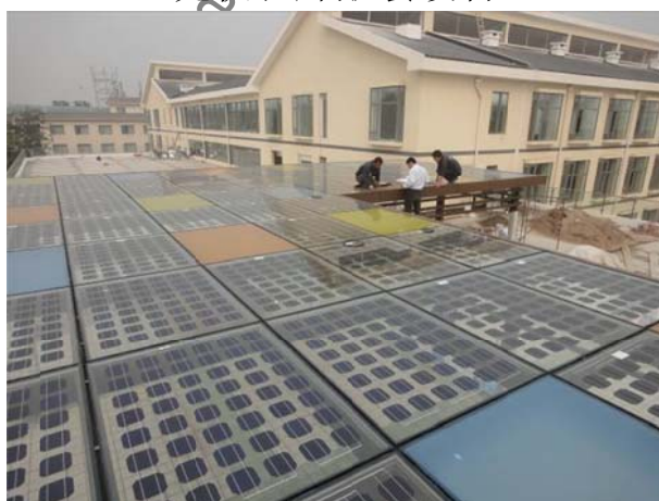
光伏长廊现场图片
